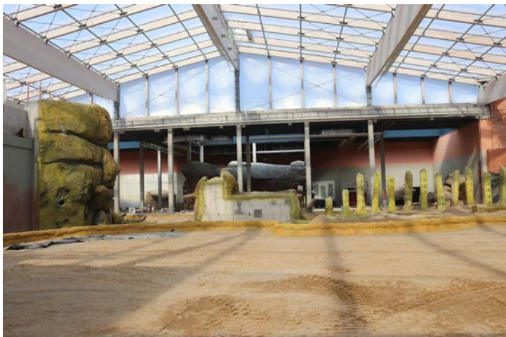
Blick in die Baustelle des Elefantenhauses. Foto: Tierpark Berlin
