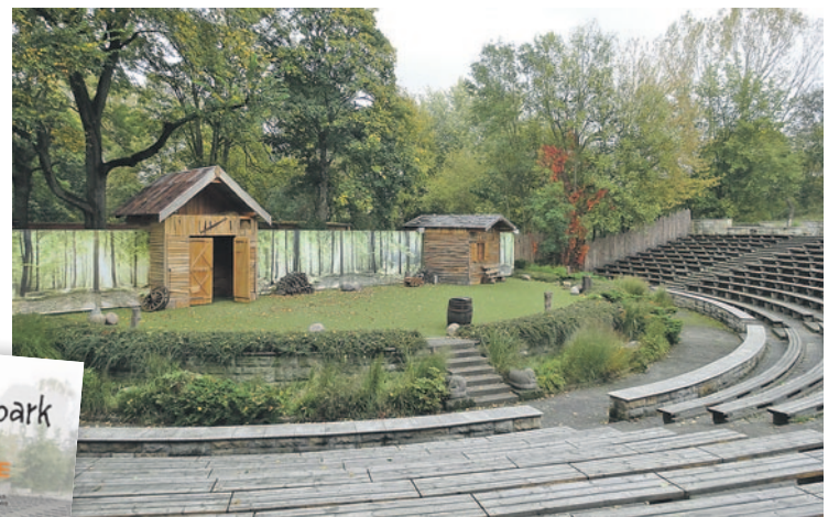
Die Freilichtbühne muss saniert werden. Foto: Förderverein
